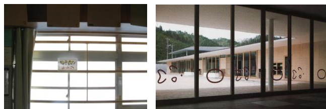
窓からの転落防止のために 窓ガラスにシールを貼り、 手すりを設けた事例 認識しやすくした事例
