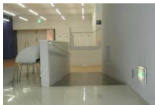
段差を解消した スロープの事例
