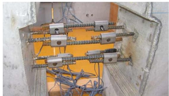
写真-1(c) フープクリップ接合の配筋状況
