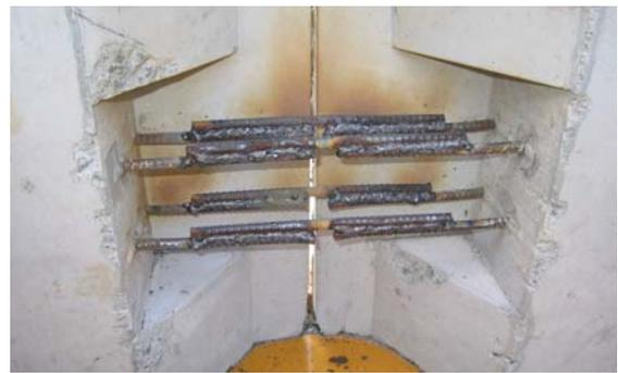
写真-1(a) フレア溶接接合の配筋状況
