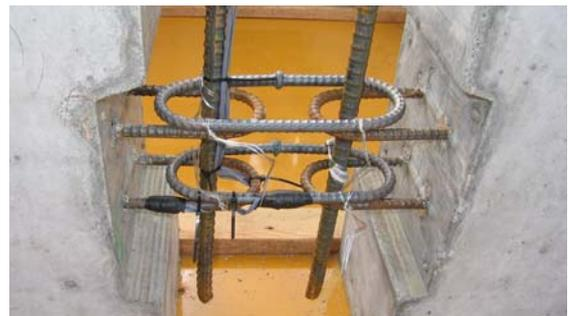
写真-1(b) フープ筋接合の配筋状況
