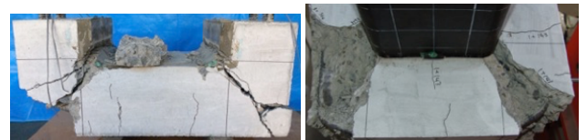
(a)要素試験体 CR2510-T (b)柱脚実験試験体 CR2510S-0-C+
